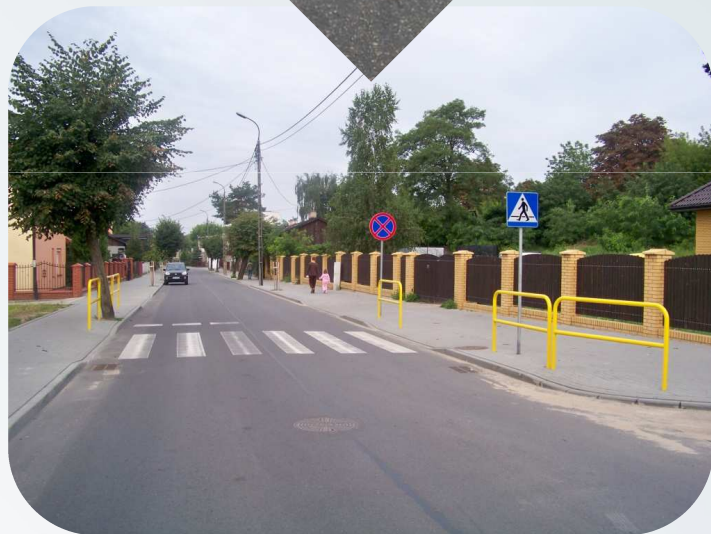
Przebudowa ulicy 22 Stycznia.
