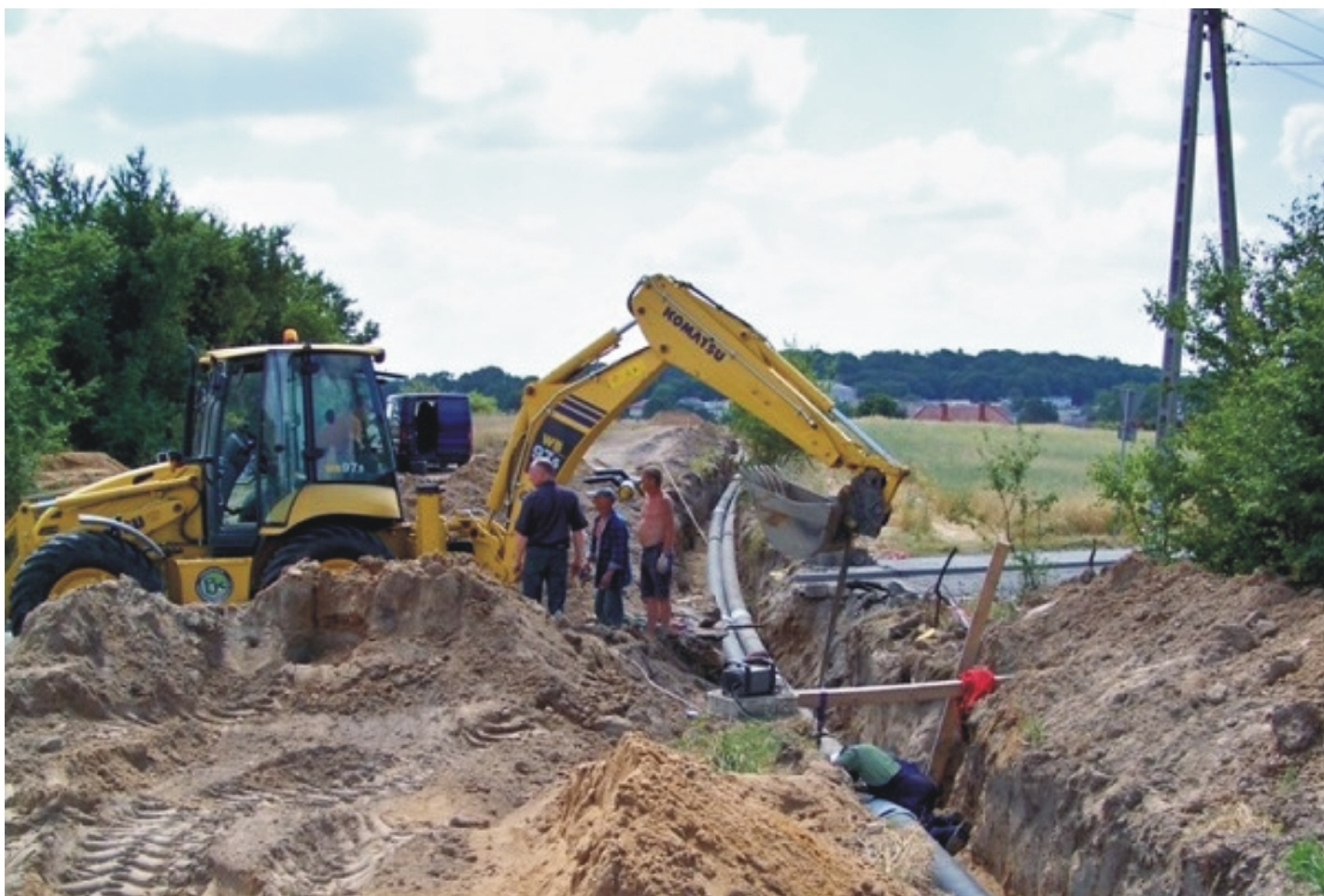
Budowa ciepłociągu na ulicy Polnej
