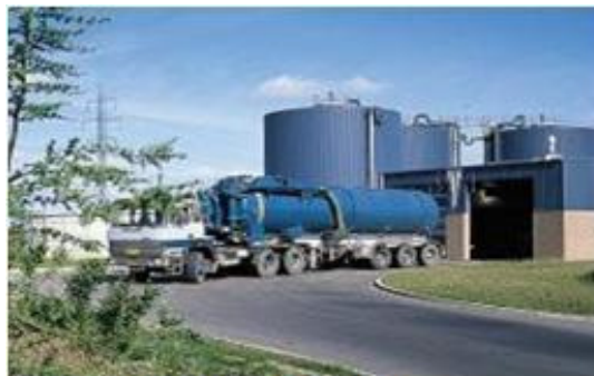
Instalacja biogazowa w Ribe (Dania)
