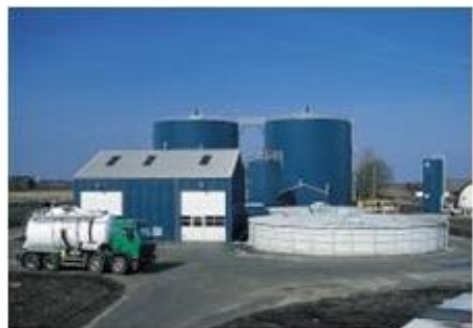
Instalacja biogazowa w Studsgaard (Dania)
