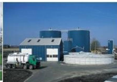
Instalacja biogazowa w Studsgaard (Dania)
