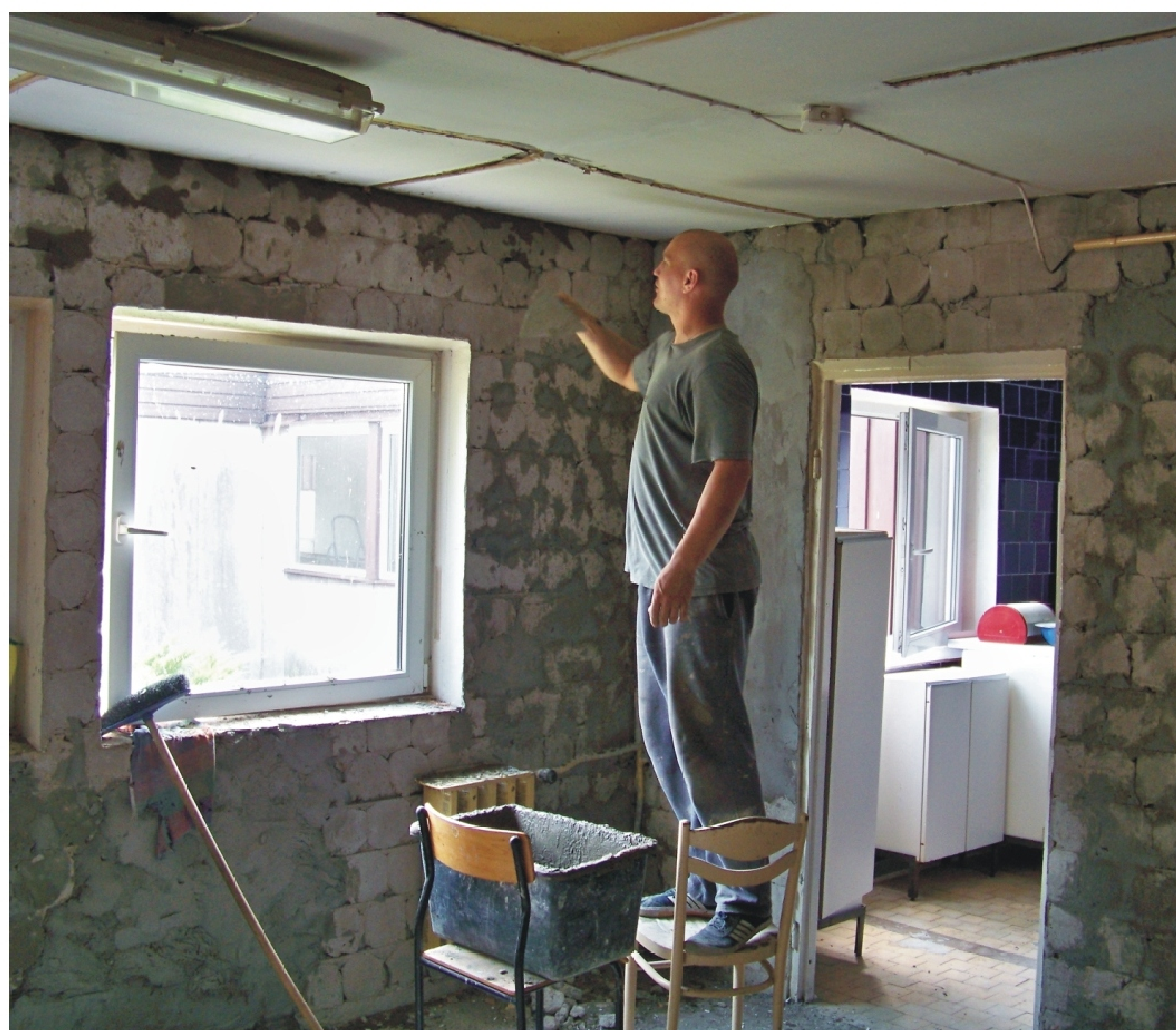
Remont pomieszczeń kuchennych w Przedszkolu Miejskim Nr 4
